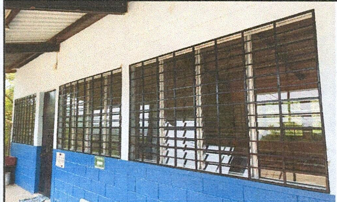
Foto 2: Mejoramiento de ventanas (instalación de ventanas tipo paleta, de vidrio y aluminio con balcones de metal)
