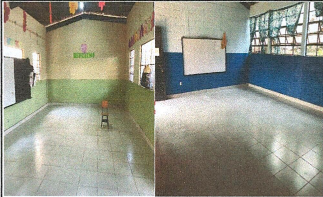
Foto 1: Mejoramiento de piso (instalación de azulejo)
